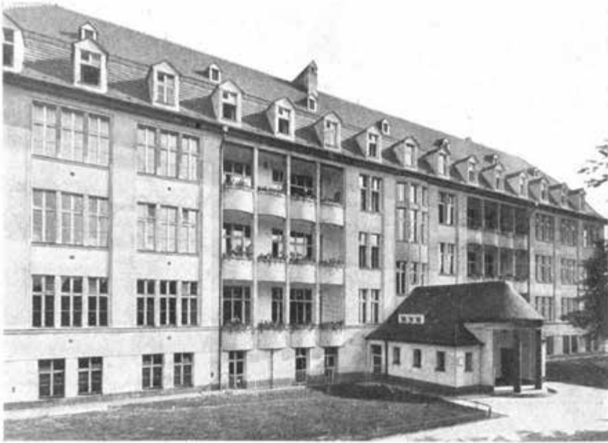
Gesamtansicht. Städtisches Säuglingsheim Breslau.
